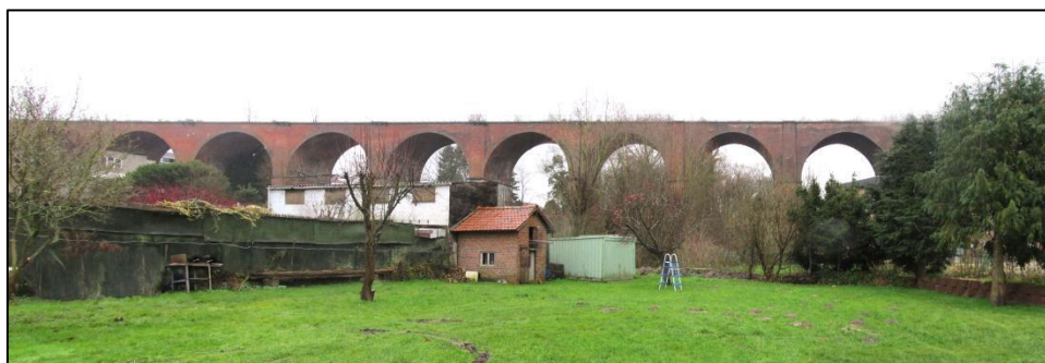
Le viaduc de l'Estrée
